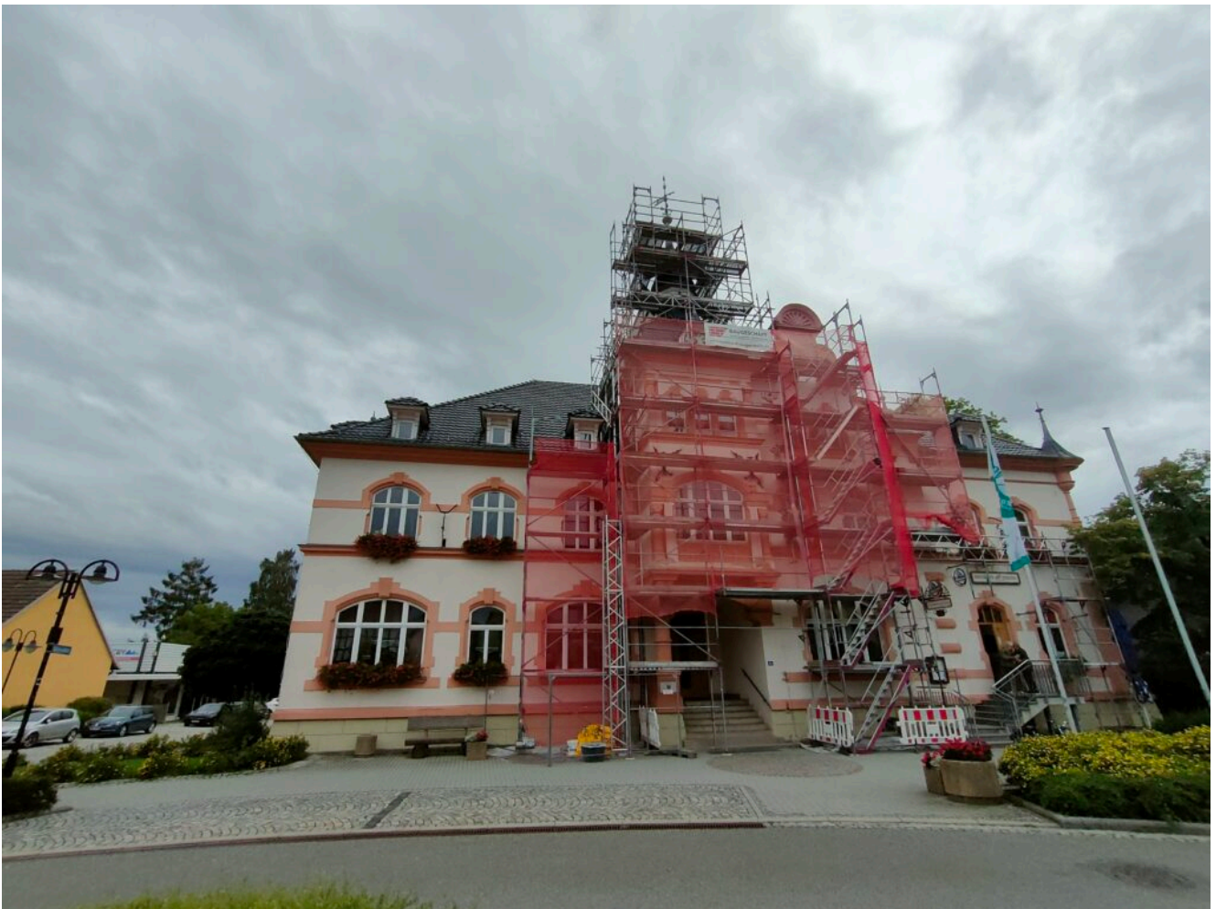
Am Rathaus wurde gebaut
