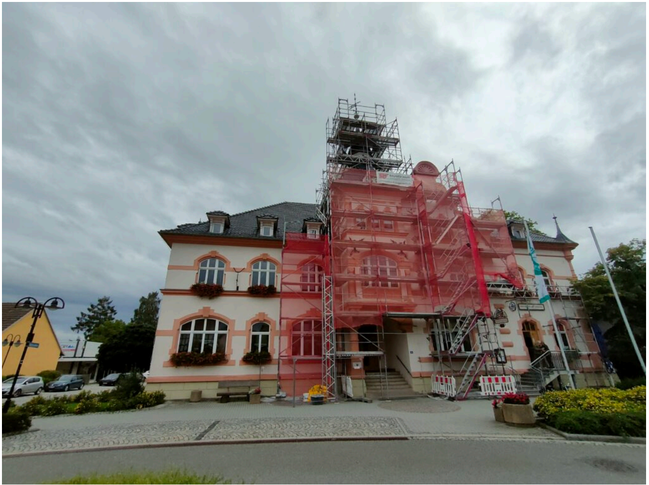
Am Rathaus wurde gebaut
